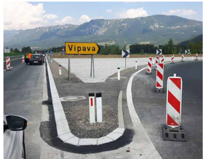
Slika 36: Izletna cona namesto jeklene varnostne ograje
