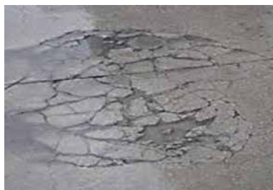
Slika 75: Vpliv soljenja na vozišče (vir: lasten posnetek, 2010)
