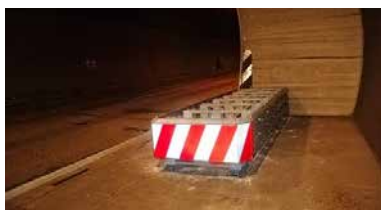
Slika 38: Blažilnik trka v predoru
