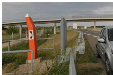
Slika 42: SOS-stebriček na avtocesti
